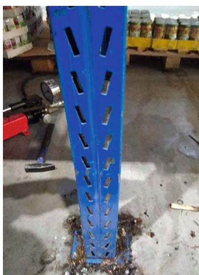
Стойки «Микрон» до форматирования и после
