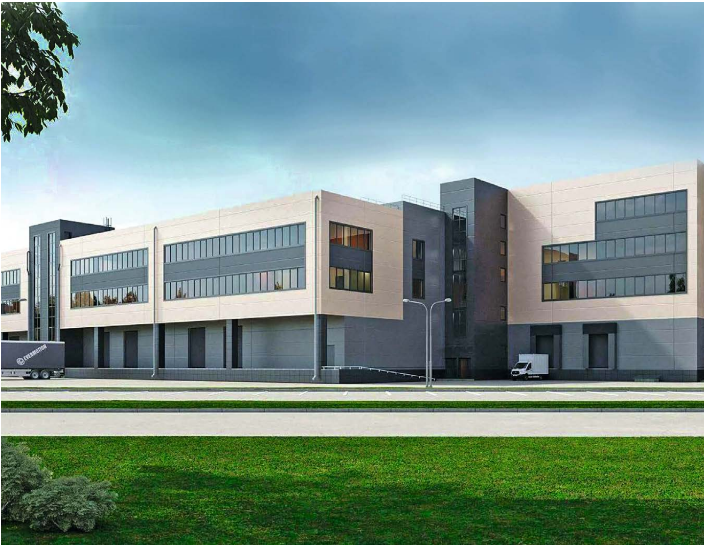
СКЛАДСКОЙ КОМПЛЕКС «НИКОЛО ХОВАНСКИЙ»
